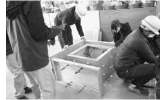
型枠施工
