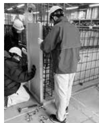
型枠施工
